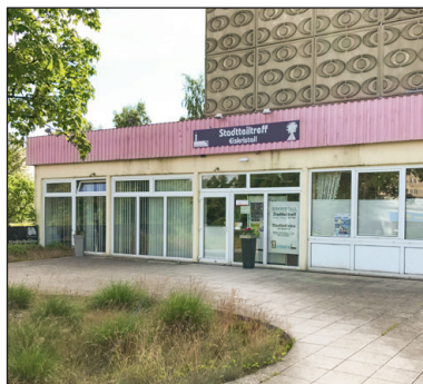
Der Stadtteiltreff „Eiskristall“ wird seit März 2009 erfolgreich vom Verein „Die Platte lebt“ e.V. betrieben. Foto: maxpress
