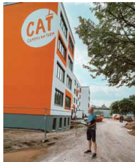
Im Herbst 2023 soll der Schulhof fertiggestellt werden
